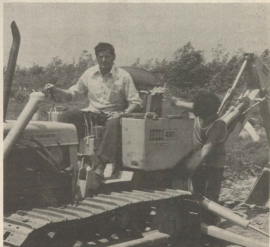
Le bulldozer équipé d'une pelle en rétro.
