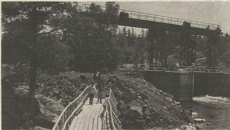
Les pistes jusqu'aux barrages de la Chaudière, sur la rivière des Français, sont coupées de ponts bâtis avec des rondins et des poutres grossières comme ceux que l'on voit sur ces photos.
