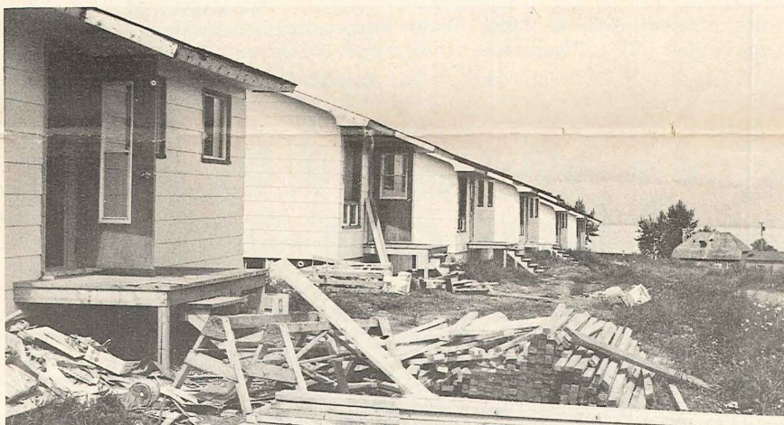
Une série de maisons unifamiliales actuellement en construction à Pointe Bleue.
